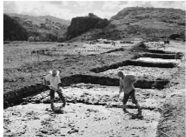
Abb. 14 Gruben zur Herstellung der Mischung aus Lehmmerde, Stroh und Wasser für die Lehmziegelproduktion
