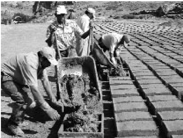
Abb. 15 Herstellung der Lehmziegel mit Holzrahmenformen (hier Doppelformen für Halbziegel). Rechts Tagesproduktionen von Lehmziegeln in verschiedenen Trockenstadien erkennbar
