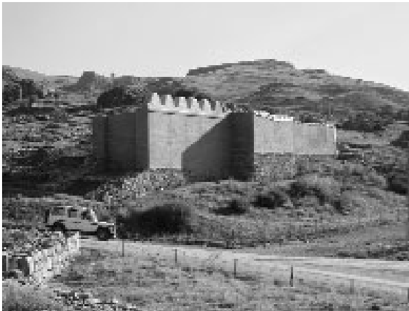
Abb. 13 Rekonstruktion eines Teilstücks der Lehmziegel-Stadtmauer, Bauzustand September 2004
