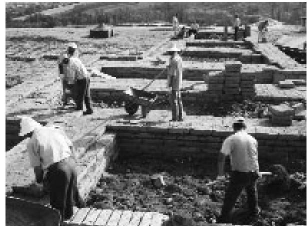
Abb. 16 Blick über die Lehmziegel-Stadtmauer mit teilweise verfüllten Kästen
