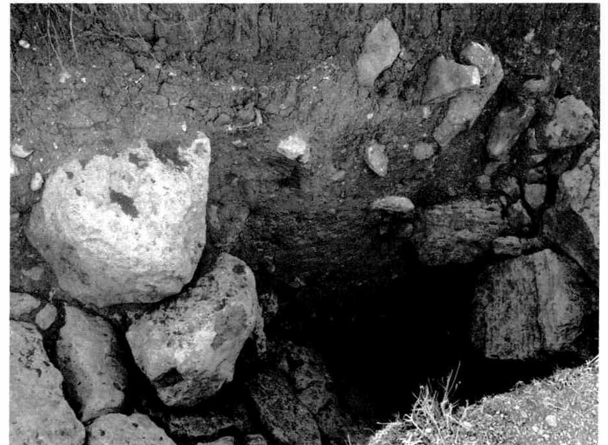
Nordwest-Damm. 1) Profil mit Dammschüttung und Dichtungskern im Schnitt 2; 2) Der Bereich zwischen den beiden wasserseitigen Pflastern im Schnitt 2: Unten links ist das ältere Pflaster zu sehen, in der rechten Bildhälfte das jüngere. Erkennbar sind die großen Fundamentsteine sowie die Pflasterung und die Hinterfüllung des jüngeren Bauwerks.
