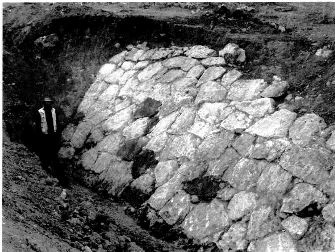
Nordwest-Damm. Luftseitige Böschungspflasterung. Stadtabgewandter Bereich ab der Bruchstelle (1) und stadtnaher Abschnitt mit erhaltener Dammkrone (2). Die Oberkante des wiederhergestellten Dammes entspricht dem originalen erhaltenen Pflasterabschluss.
