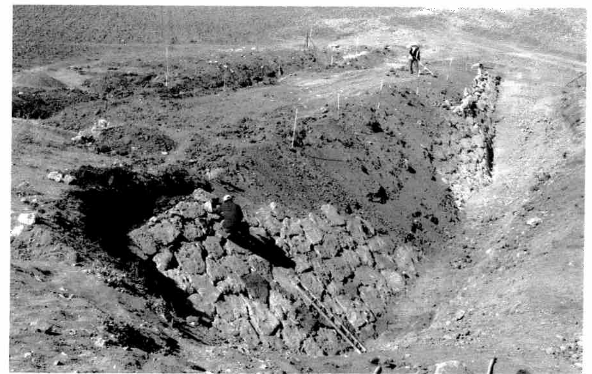
Nordwest-Damm. Freilegungsarbeiten der luftseitigen Böschung mit Hilfe eines Baggers (1) und Restaurierungsarbeiten (2). Die Höhe des aufgeschütteten Erdmaterials auf dem Damm entspricht der originalen Dammhöhe.
