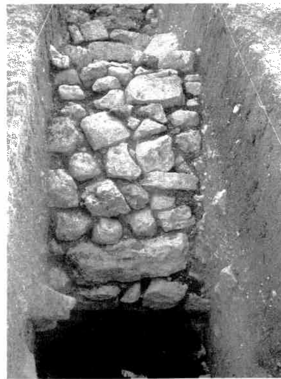
Nordwest-Damm. Detailfotos in Schnitt 2. 1) Luftseitiges Böschungspflaster; 2) Substruktion; 3) Älteres wasserseitiges Böschungspflaster; 4) Jüngeres wasserseitiges Böschungspflaster
