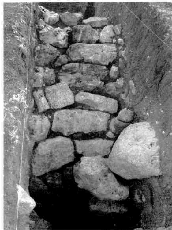
Nordwest-Damm. Detailfotos in Schnitt 2. 1) Luftseitiges Böschungspflaster; 2) Substruktion; 3) Älteres wasserseitiges Böschungspflaster; 4) Jüngeres wasserseitiges Böschungspflaster
