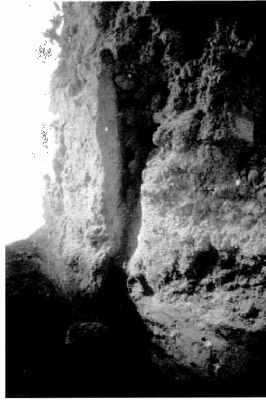
Res. 5 Kapı kasasını yerleştirmek için duvara açılmış yuva.
