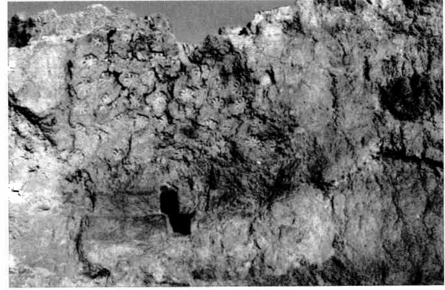
Res. 9 Koridorun kapatılan kısmında duvar sıvasına yapılmış baskılar.
