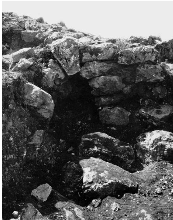
Abb. 13 Poternenmauer in Hattuša (mindestens 16. Jh. v. Chr.): Innerer Ausgang von Poterne 3 mit Kragsteingewölbe und Scheitelstein
