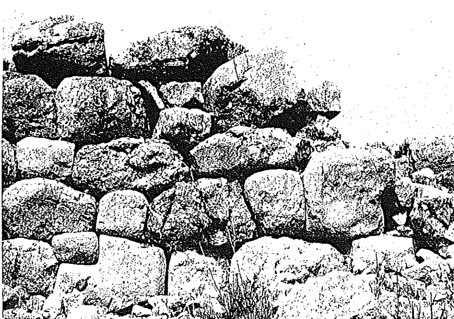
2 Ostmauer von Raum G
