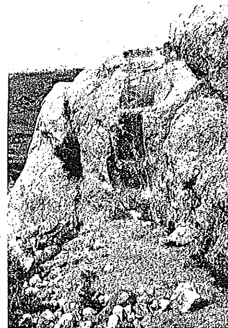
3 Felsarbeiten für Raum P
