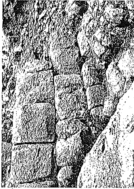
5 Quadermauer an der Südseite von Raum K
